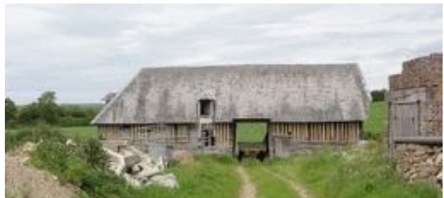
Bâtiment à colombages, ancienne annexe agricole Le Radier (Hotot-en-Auge)
