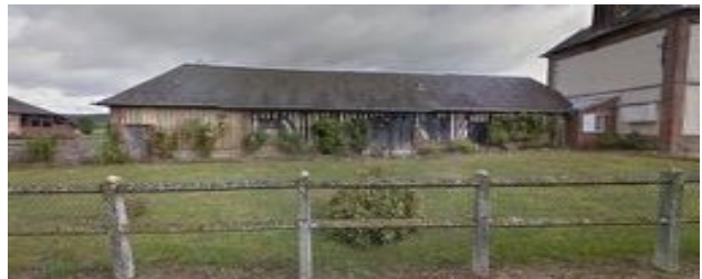
Bâtiment à colombages, ancienne annexe agricole Lieu Roux (Rusmesnil)
